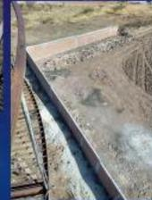
380 mts lineales con tabique rojo, dalas o través y castillos de concreto armado con varilla de 3/8, zapatas de concreto armado de 15 cm de espesor con muro de enrase de tabicón.
