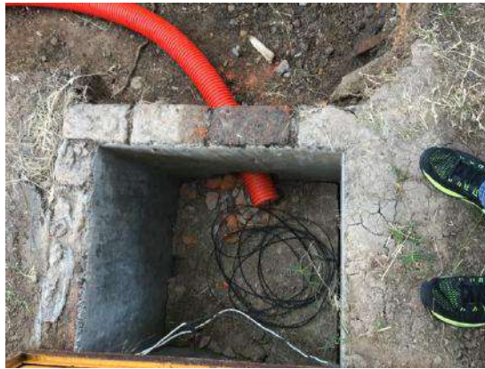
Figura 5. Instalación de cableado estructurado y nodos
