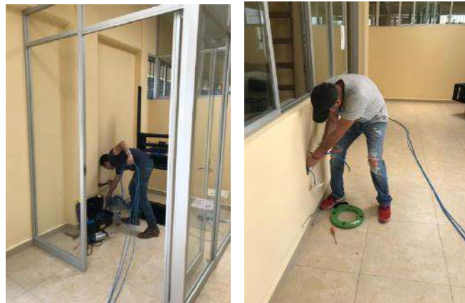
Figura 7. Instalación de cableado estructurado en Ciencias Forestales
