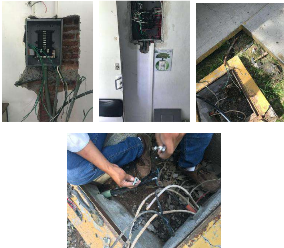
Figura 9. Mantenimiento y cambio de cableado eléctrico
