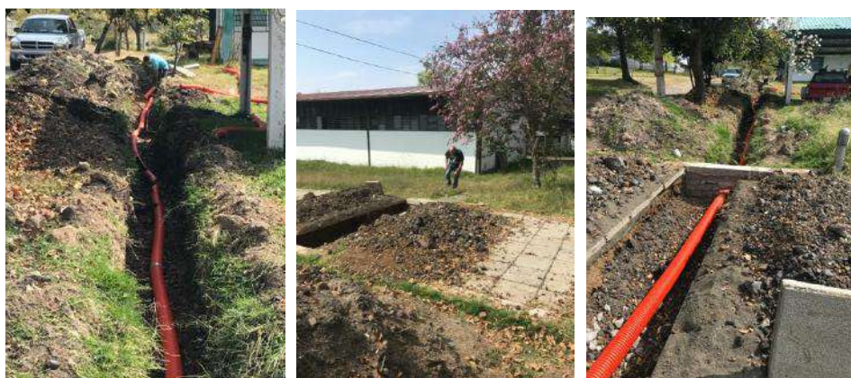
Figura 4. Instalación y obra civil de fibra óptica
