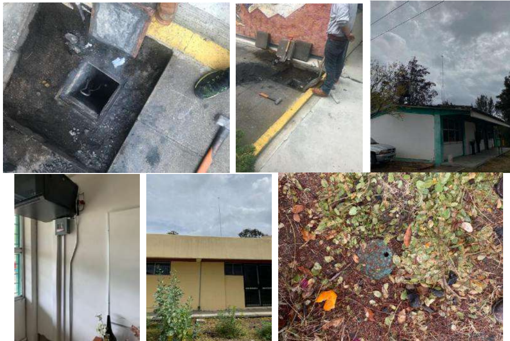
Figura 11, Mantenimiento de pararrayos y tierras físicas
